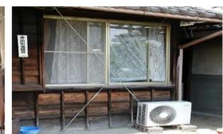
B邸 (外付けブレース工法)
