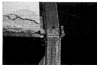
写真4 地震被害例 3) (B-1)
